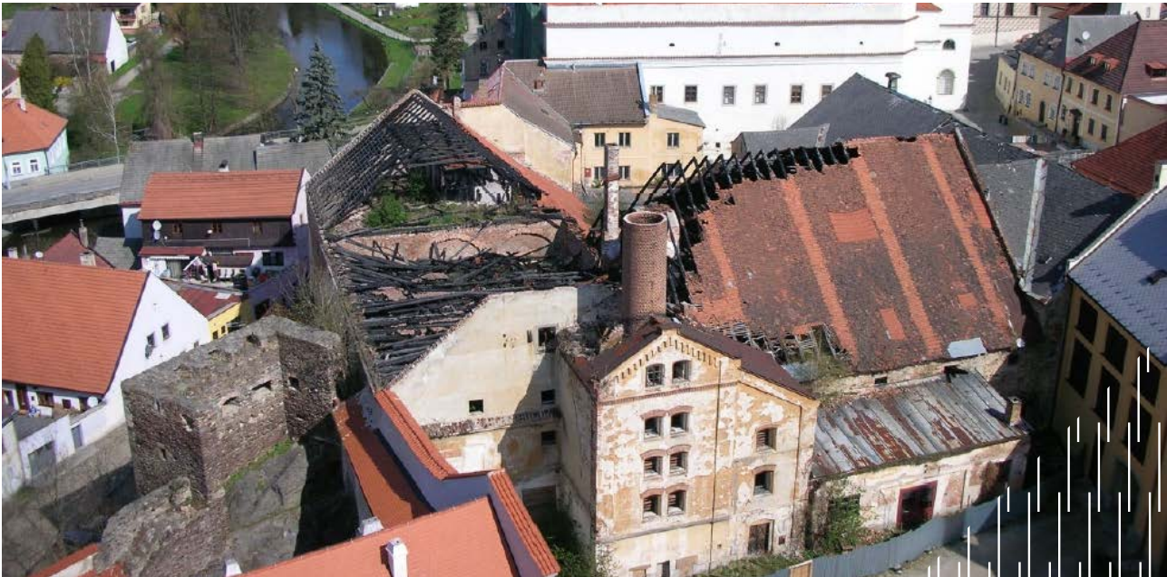
Na obnovu zámeckého pivovaru získalo město Jindřichův Hradec dotaci od SFPI/MMR i z programu MPO. Zdroj: Jindřichův Hradec
