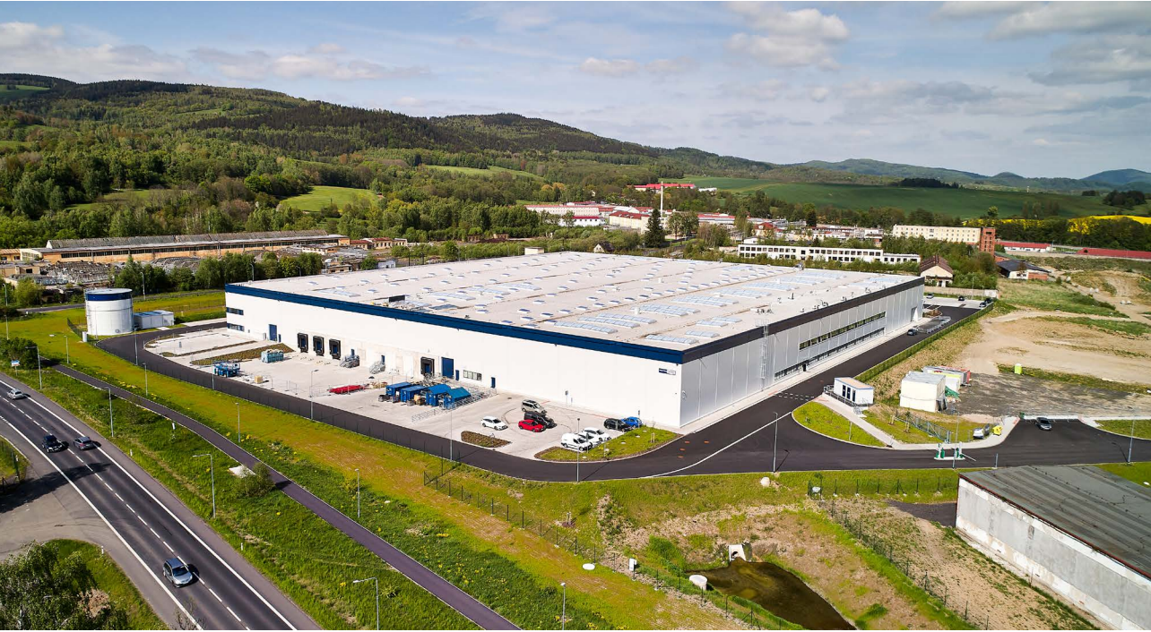
Panattoni Park Ostrov North, Zdroj: Panattoni
