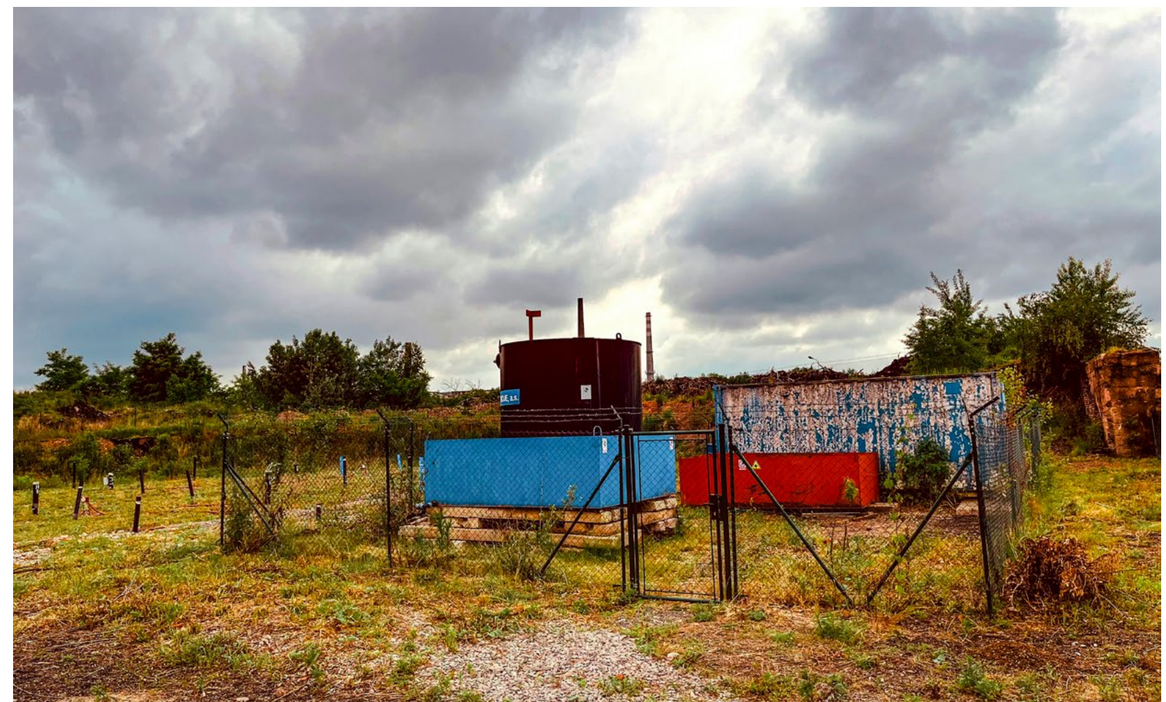
Probíhající sanace v prostoru bývalých dehtových jezírek
