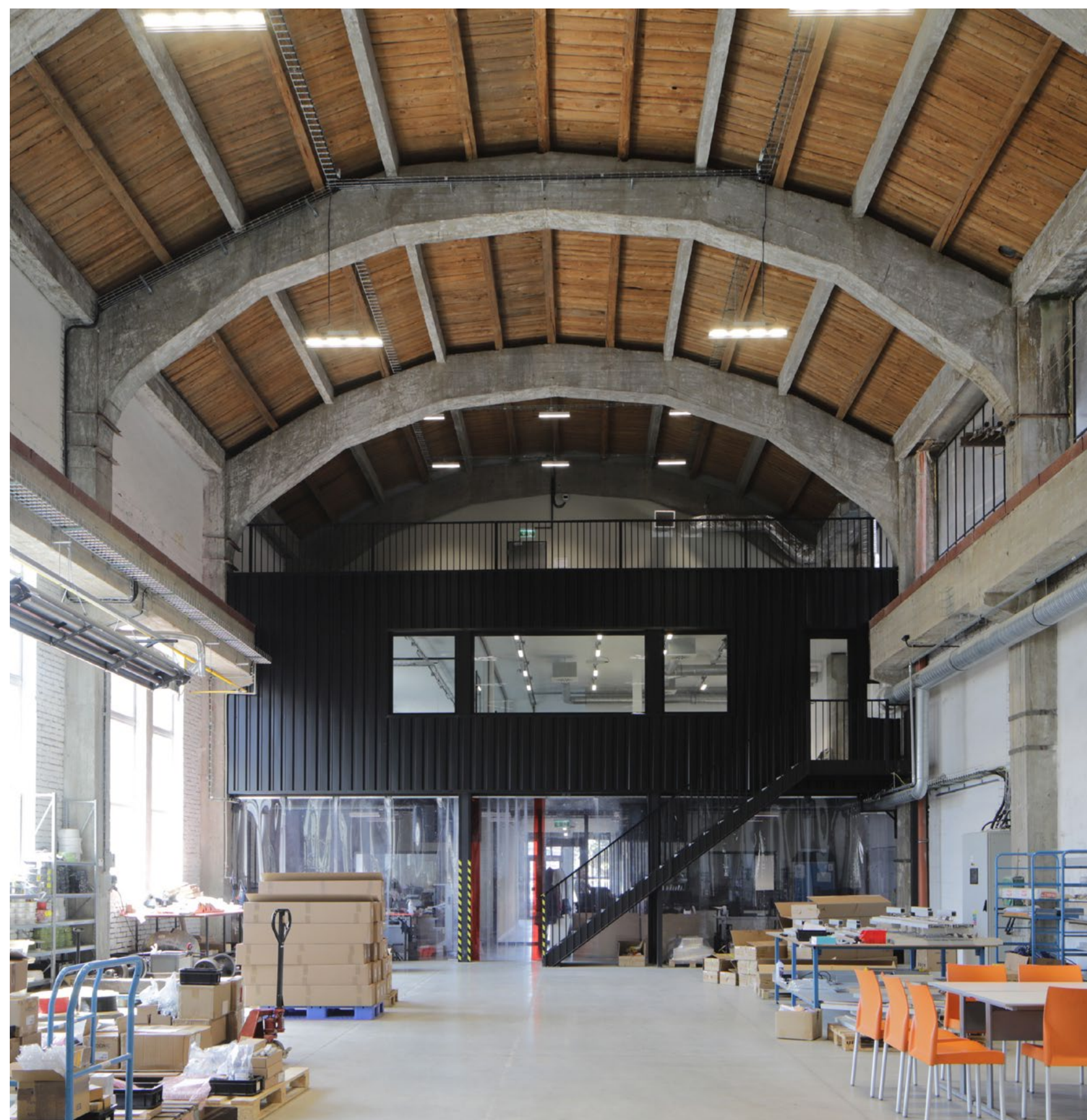
Nově vestavěná administrativní část výroby ▶▶▶
