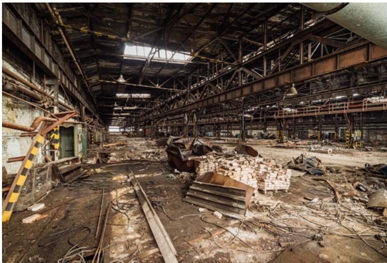
Hala bývalé ocelárny Poldi Kladno
