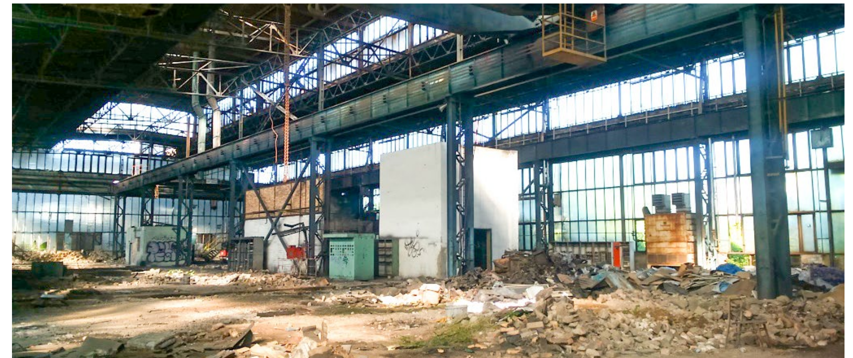
Dnes již zbouraná hala na stavebním pozemku – stav v roce 2015
