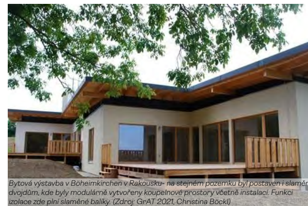
Bytová výstavba v Böheimkirchen v Rakousku (Life Cycle Habitation) – ukázková CO 2 -neutrální bytová výstavba složená z jednoho bytového domu složeného ze 4 modulů. Nosná konstrukce je ze dřeva a izolaci tvoří foukaná sláma. (Zdroj: GrAT 2021, Christina Böckl)
