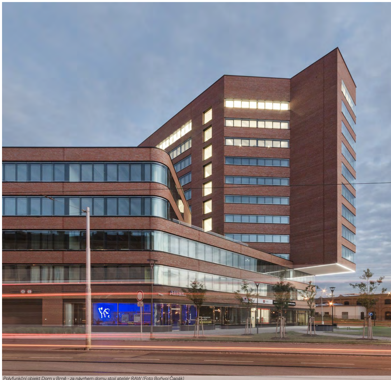
Polyfunkční objekt Dorn v Brně - za návrhem domu stojí ateliér RAW (Foto Bořivoj Čapák)
