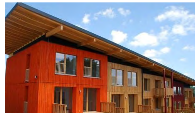
Bytová výstavba v Böheimkirchen v Rakousku (Life Cycle Habitation) – ukázková CO 2 -neutrální bytová výstavba složená z jednoho bytového domu složeného ze 4 modulů. Nosná konstrukce je ze dřeva a izolaci tvoří foukaná sláma. (Zdroj: GrAT 2021, Christina Böckl)
