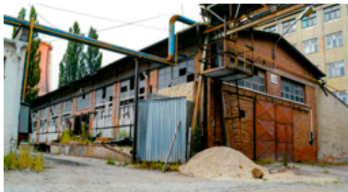
Gradior Tech a.s. - objekt před rekonstrukcí
