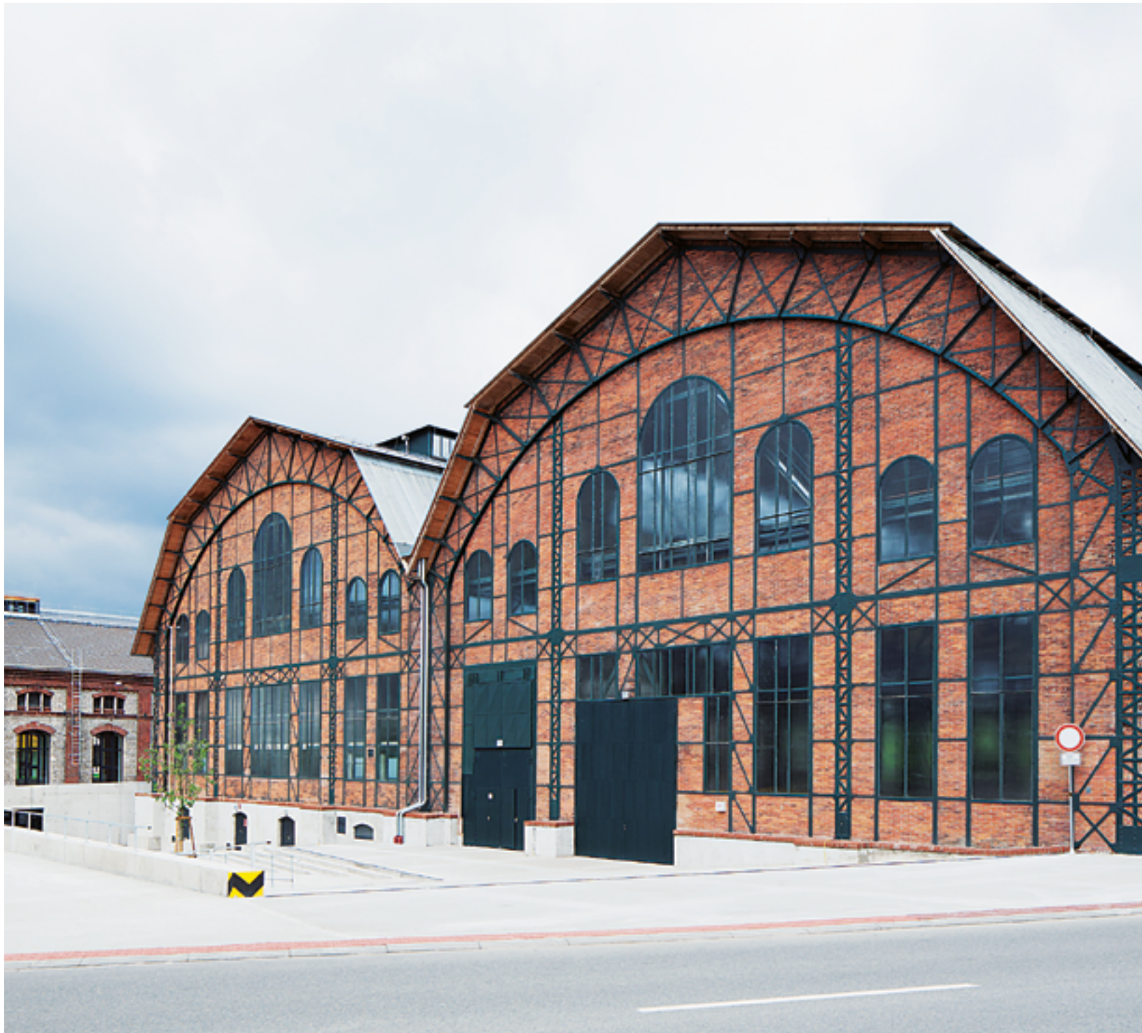
Trojhalí Karolina - Elektrocentrála koksovy Karolina a Energetická ústředna č.III, Ostrava - Moravská Ostrava
