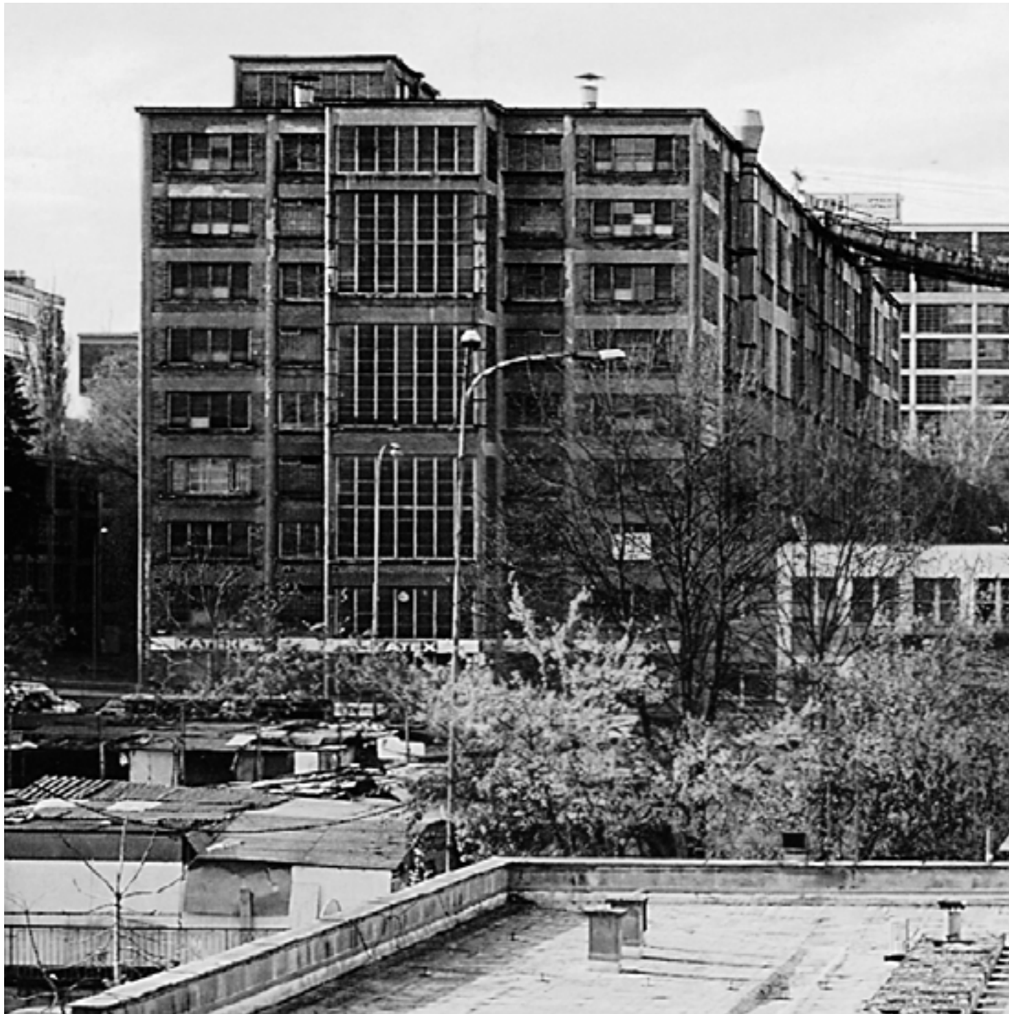
Batův institut - Baťovy závody, výrobní budovy 14 a 15 před rekonstrukcí, Zlín
